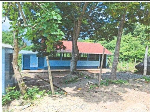
Foto1: Mejoramiento de muro perimetral, entrada principal.
